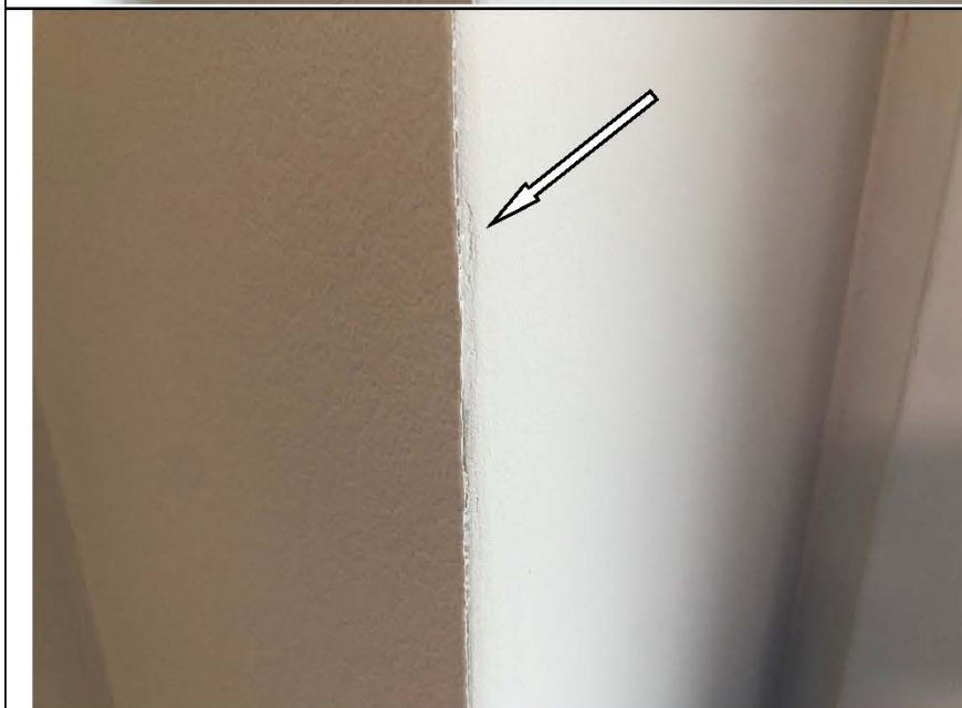
Фото №32. Неровности, сколы на окрашенных откосах в спальне в квартире.
