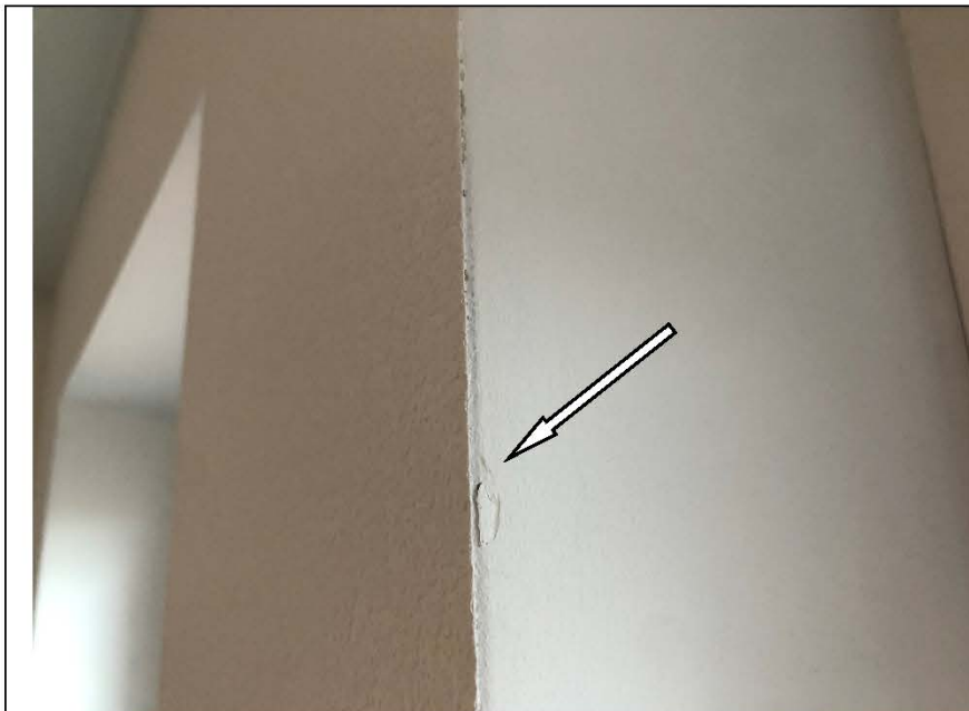
Фото №31. Неровности, сколы на окрашенных откосах в кухне в квартире.
