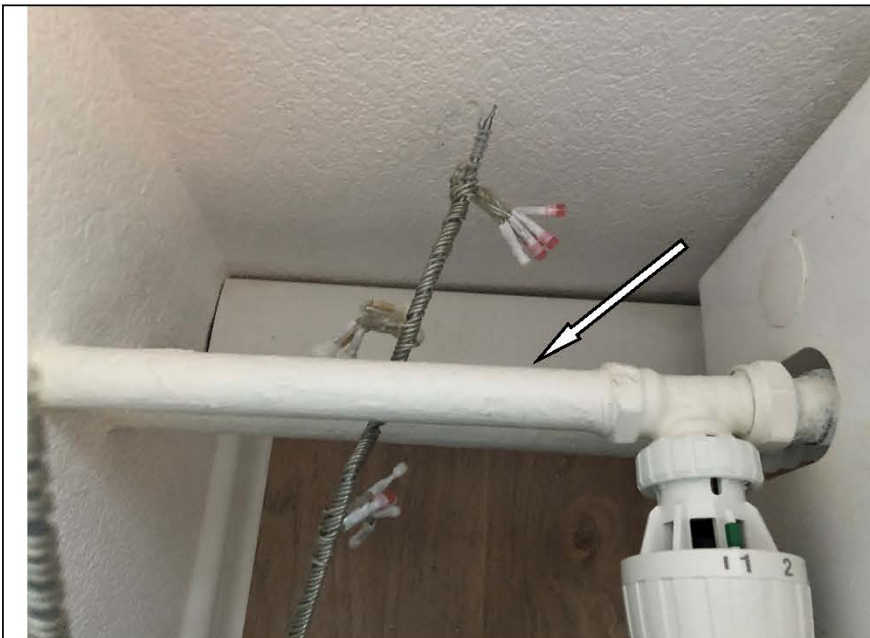
Фото №40. Неровности, сколы на окрашенных трубах отопления в кухне в квартире.
