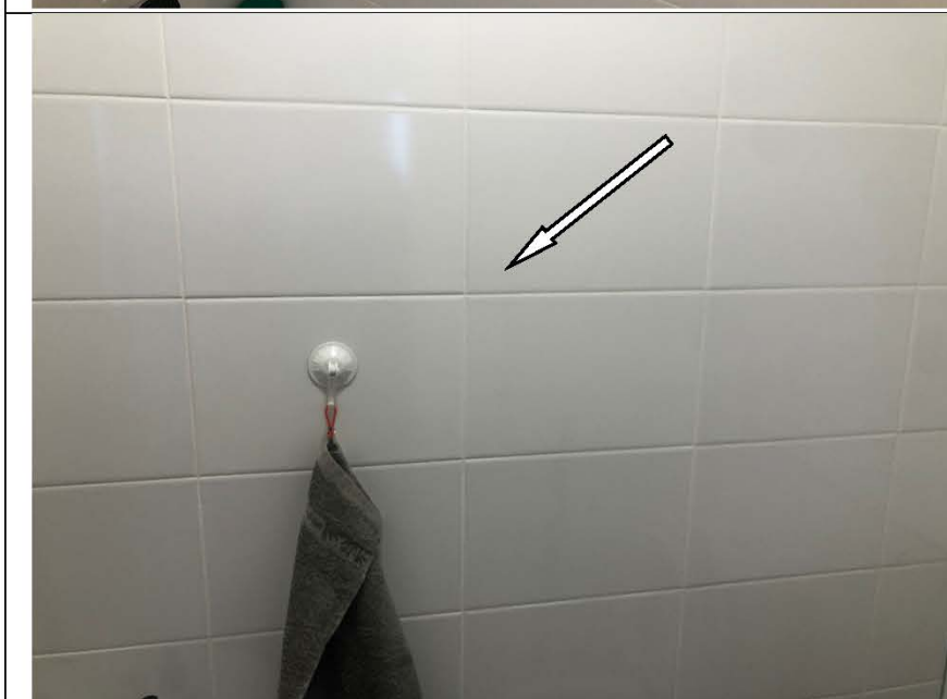
Фото №51. Разный цвет настенной керамической плитки в санузле в квартире.
