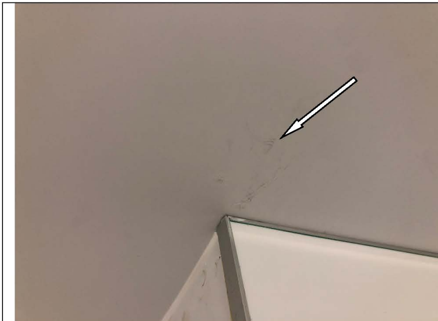
Фото №52. Загрязнение на окрашенном потолке в ванной комнате в квартире.
