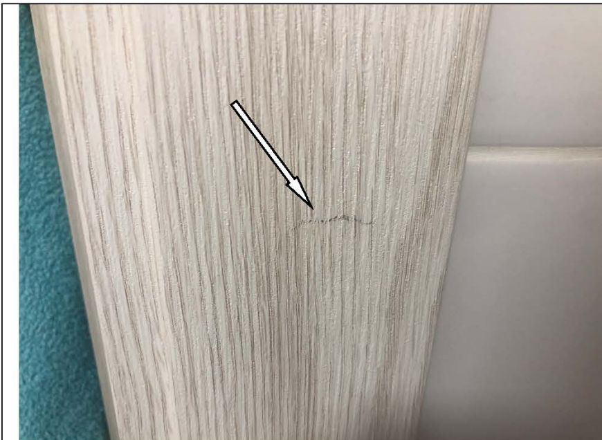
Фото №28. Загрязнение на наличнике деревянного дверного блока в ванной комнате в квартире.
