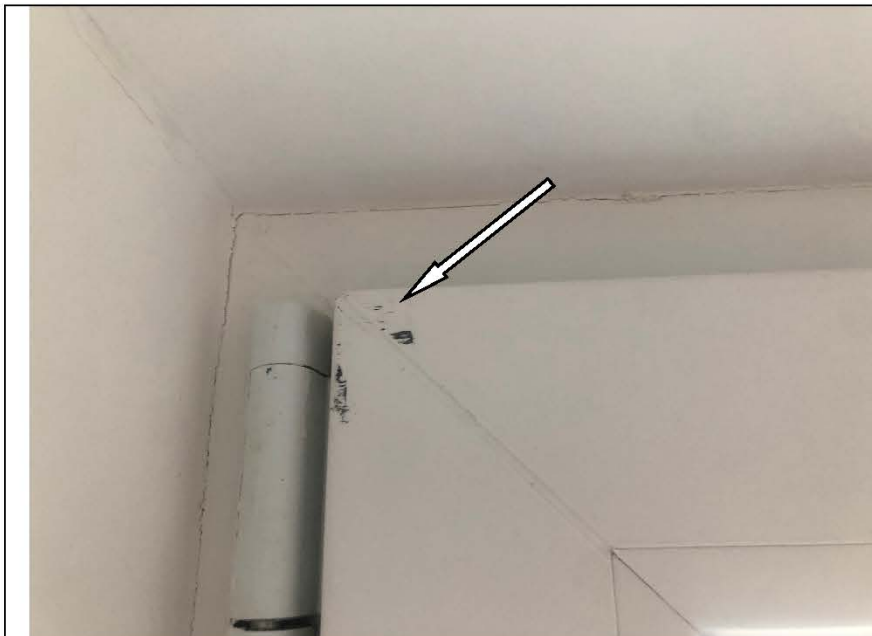
Фото №46. Загрязнение профиля оконного блока ПВХ в детской в квартире.
