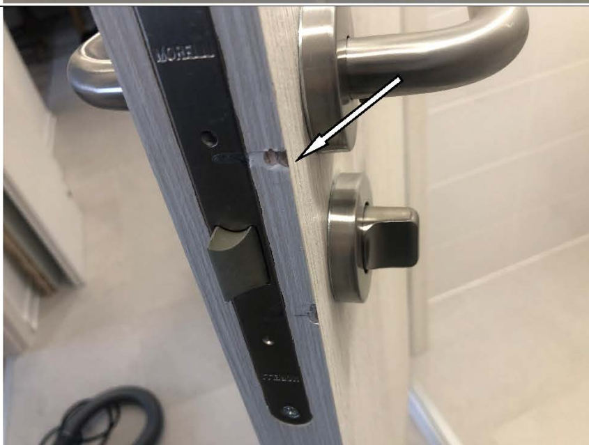
Фото №60. Сколы на полотне деревянного дверного блока в санузле в квартире.
