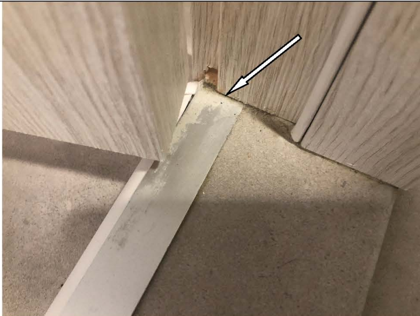
Фото №58. Загрязнение на металлическом порожке в ванной комнате в квартире.
