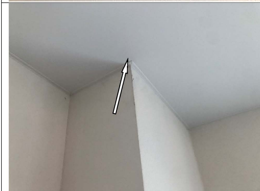
Фото №15. Загрязнение полотна натяжного потолка в кухне в квартире.
