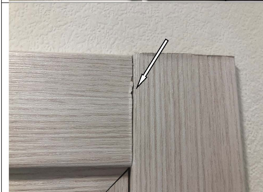
Фото №27. Сколы на наличнике деревянного дверного блока в детской в квартире.
