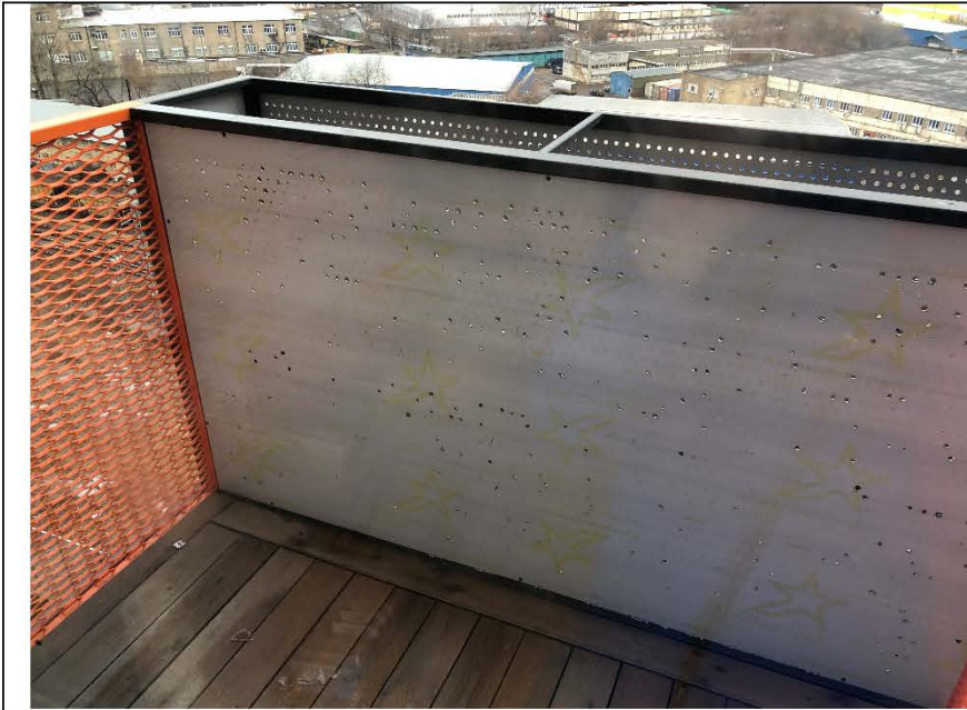
Фото №7. Общий вид балкона в квартире.
