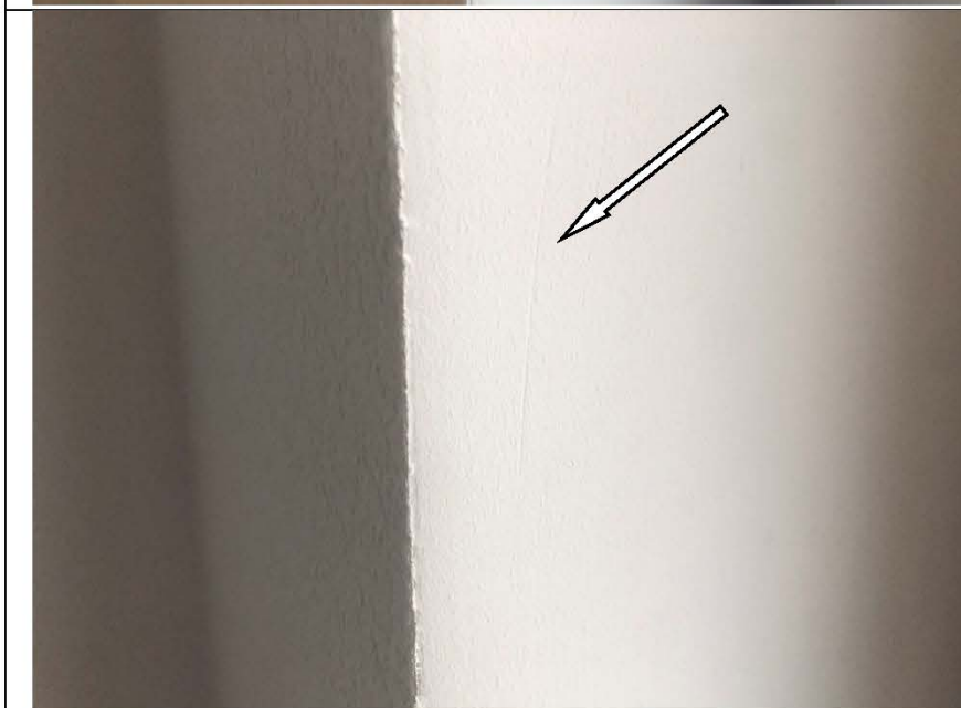
Фото №33. Неровности, сколы на окрашенных откосах в детской в квартире.
