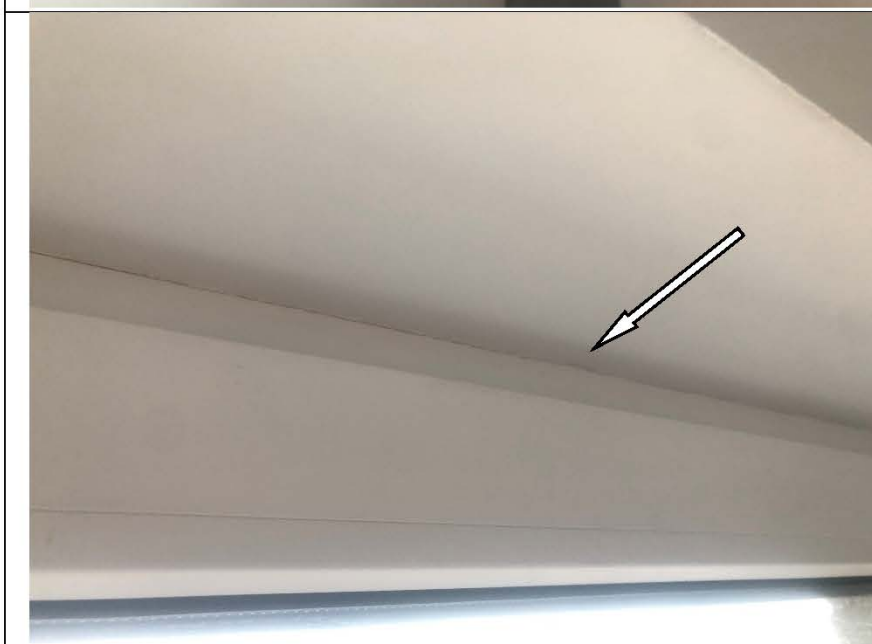
Фото №36. Инфильтрация оконного блока ПВХ в детской в квартире.
