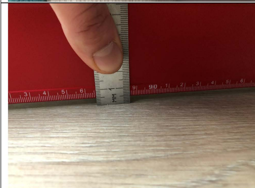
Фото №29. Измерение напольного покрытия в кухне в квартире.
