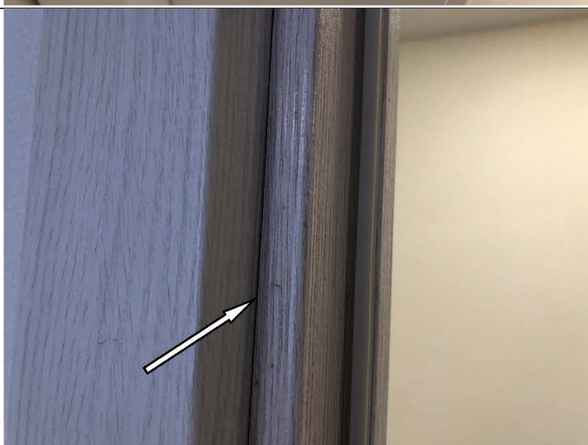
Фото №24. Загрязнение на коробке деревянного дверного блока в спальне в квартире.
