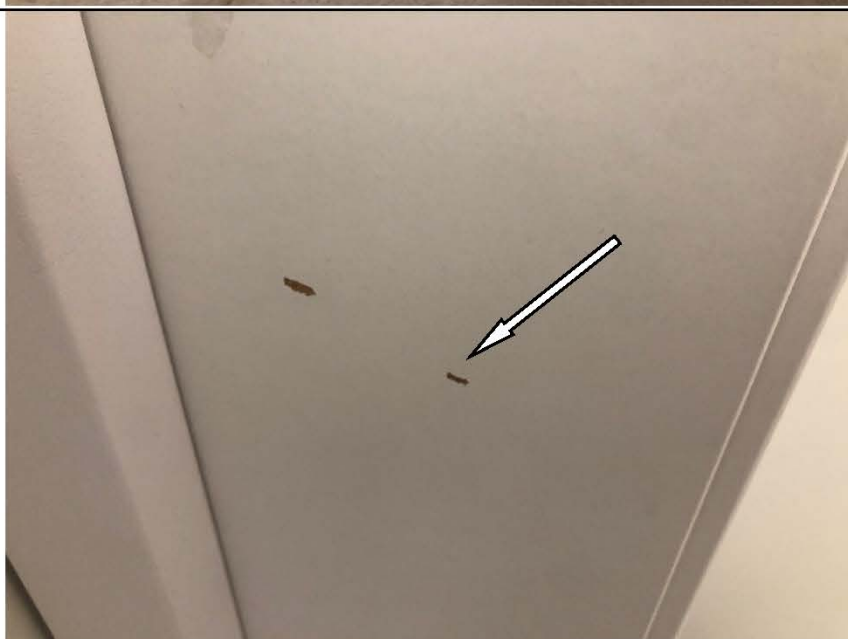
Фото №23. Скол на коробке комбинированного дверного блока в коридоре в квартире.
