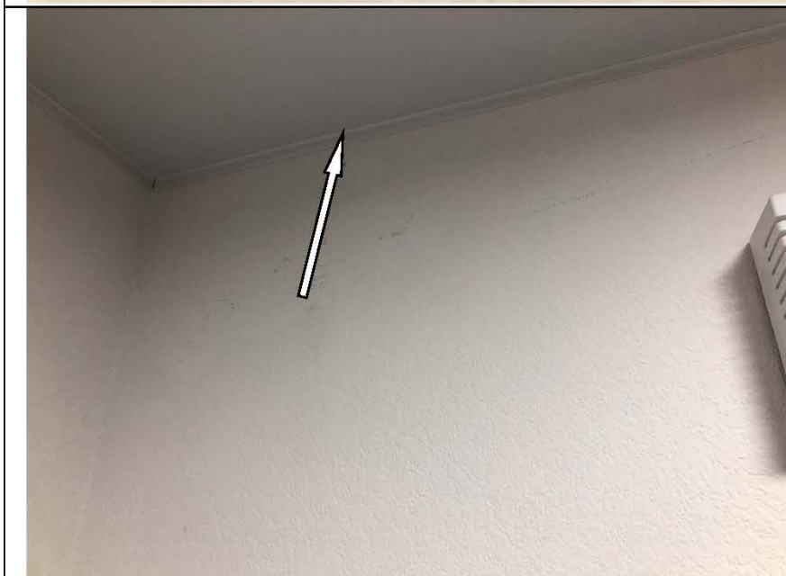
Фото №14. Загрязнение полотна натяжного потолка в коридоре в квартире.
