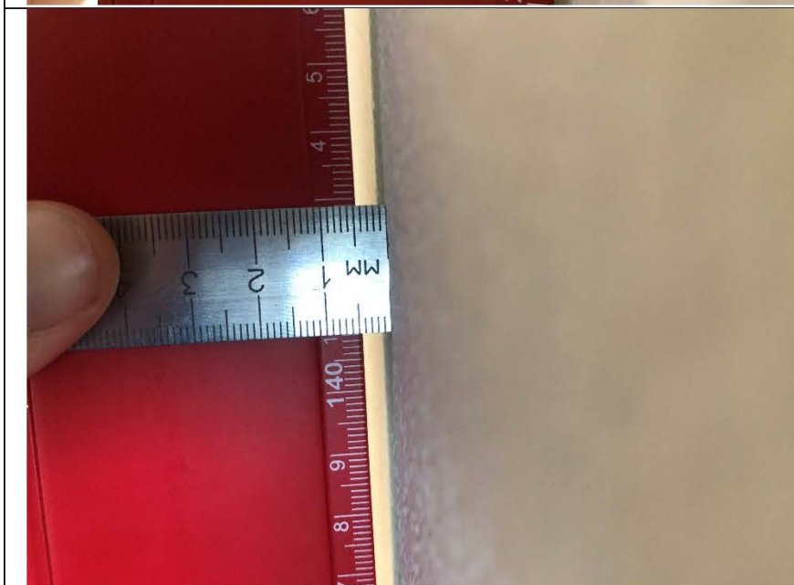
Фото №12. Измерение стен детской в квартире.
