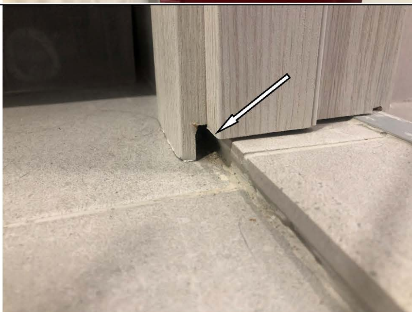
Фото №56. Наличник деревянного дверного блока не достает до напольного покрытия в ванной комнате в квартире.
