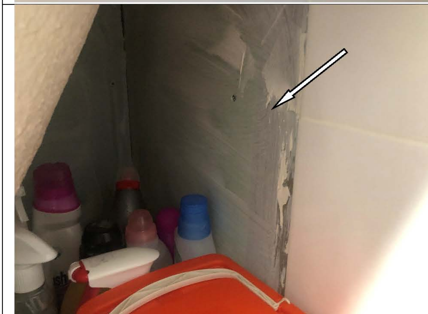
Фото №54. Частично не хватает настенной керамической плитки в ванной комнате в квартире.
