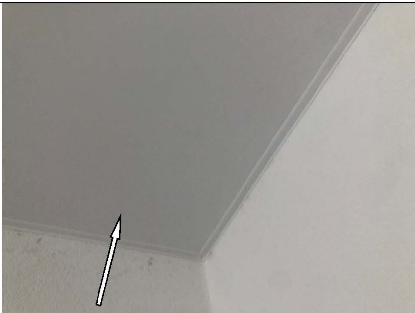
Фото №16. Загрязнение полотна натяжного потолка в детской в квартире.
