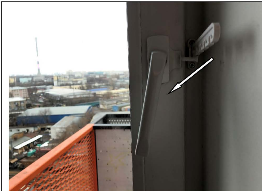
Фото №34. Не отрегулирована фурнитура оконного блока ПВХ в кухне в квартире.
