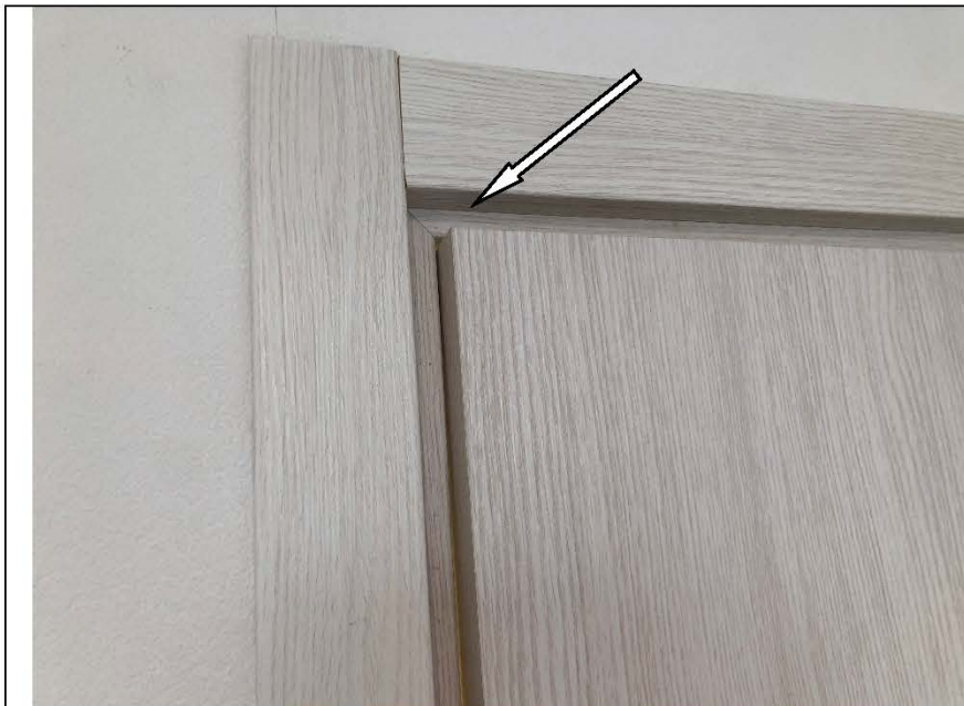
Фото №43. Не закрывается свободно дверь в спальне в квартире.
