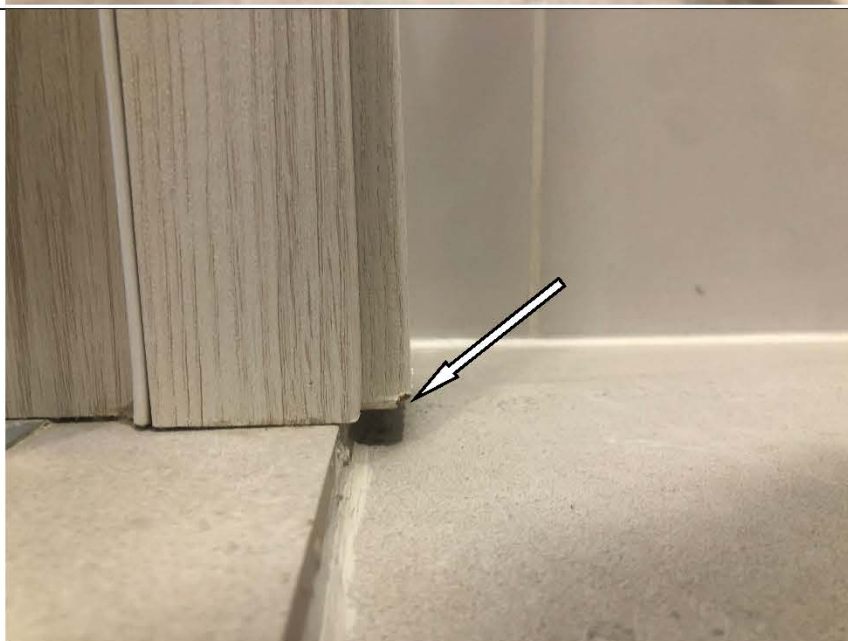
Фото №57. Наличник деревянного дверного блока не достает до напольного покрытия в санузле в квартире.
