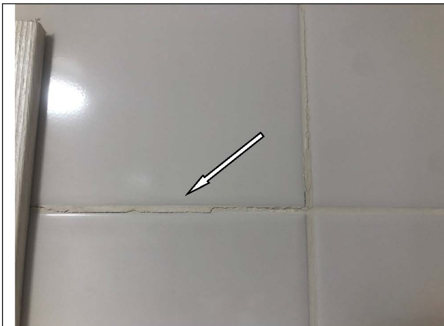
Фото №49. Неровный шов настенной керамической плитки в ванной комнате в квартире.
