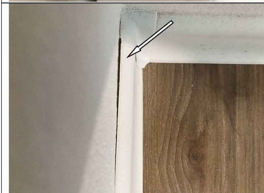
Фото №47. Неплотное прилегание напольного плинтуса ПВХ к стене в спальне в квартире.
