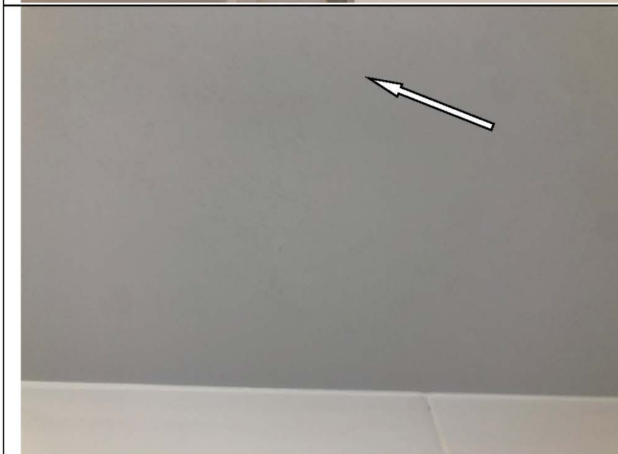
Фото №53. Загрязнение на окрашенном потолке в санузле в квартире.
