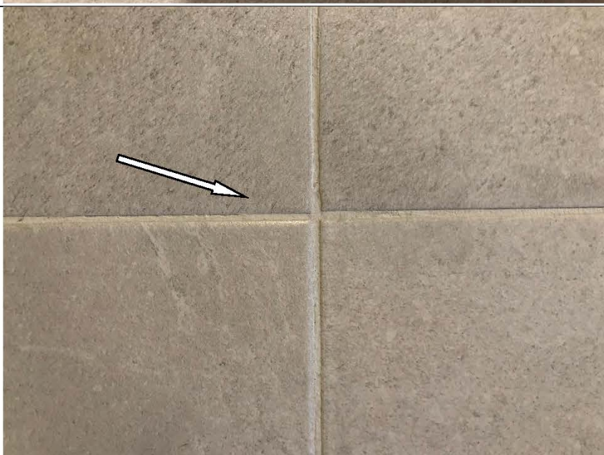
Фото №18. Неровный шов напольной керамической плитки в кухне в квартире.
