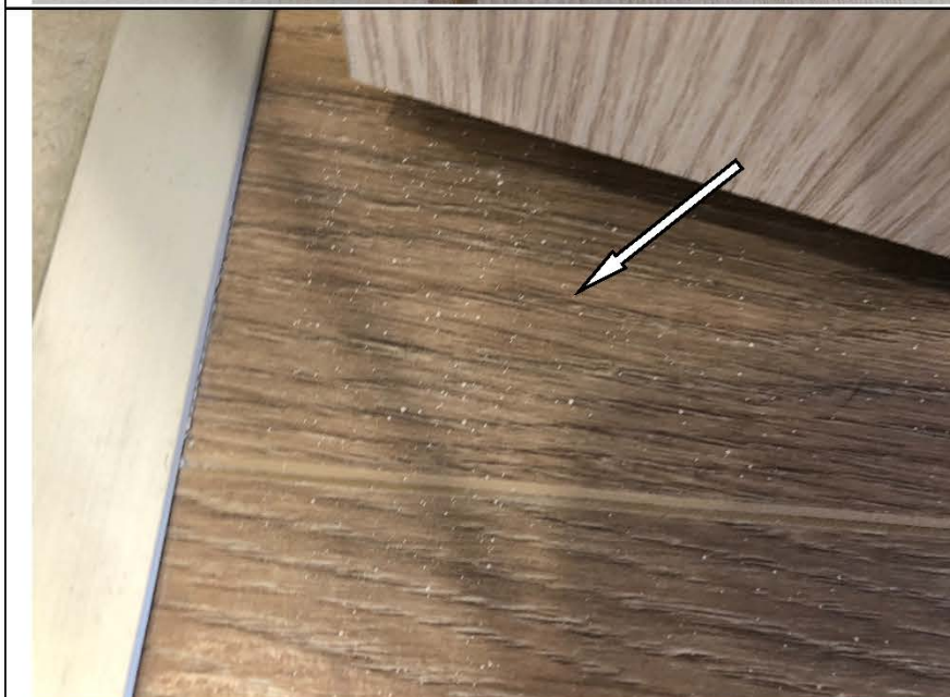
Фото №44. Загрязнение ламината в спальне в квартире.
