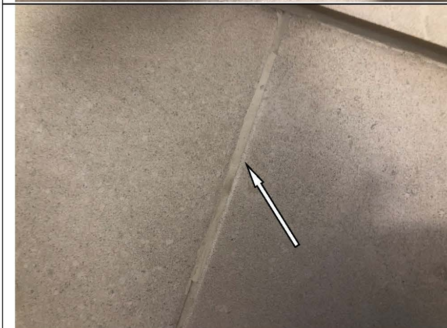
Фото №20. Неровный шов напольной керамической плитки в санузле в квартире.
