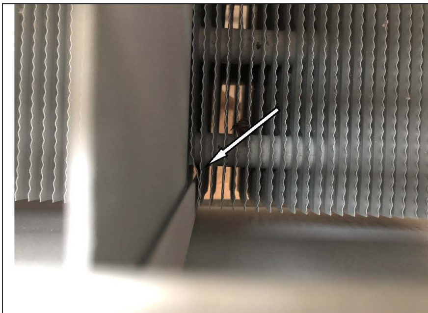
Фото №37. Замятие на радиаторе в кухне в квартире.
