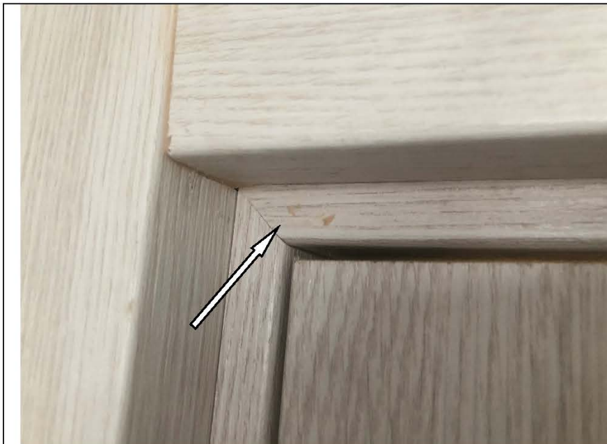
Фото №25. Загрязнение на коробке деревянного дверного блока в детской в квартире.
