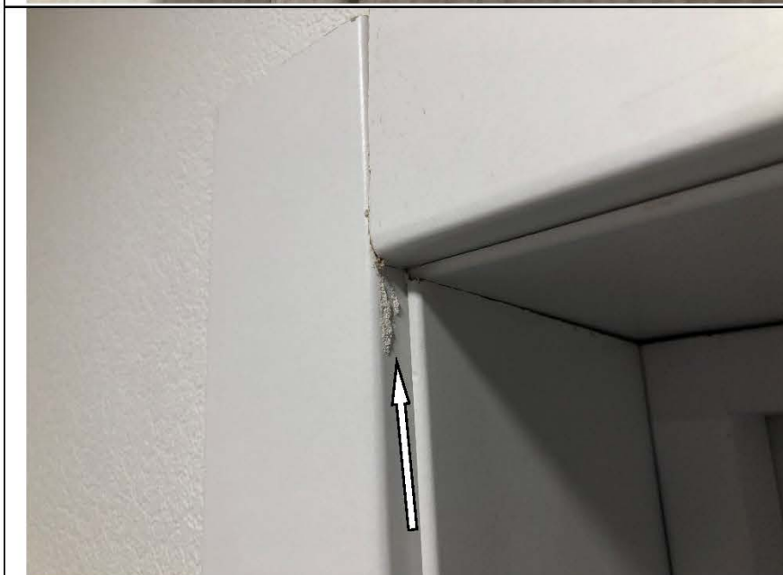
Фото №26. Загрязнение на наличнике комбинированного дверного блока в коридоре в квартире.
